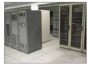
Sebbene l'impianto di condizionamento dell'aria del centro di calcolo mantenga sotto controllo la temperatura generale dei locali, è alcune volte necessario effettuare controlli in particolari punti dei locali stessi e tra i rack. Dei sensori posti strategicamente possono rilevare possibili problemi causati dal degrado dell'impianto di condizionamento, dai nuovi server installati e dagli spostamenti dei rack.
