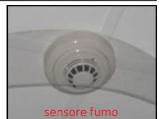
L'allarme è ovviamente puntuale e viene univocamente identificato il singolo sensore e la sede che ha generato l'allarme stesso. Dalla mappa della specifica sede è visibile il sensore che ha generato l'allarme e la sua posizione fisica.
